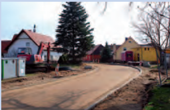
Die Arbeiten in Frankenförde wurden vor wenigen Wochen beendet. Hier sind die Leitungen bereits verlegt.
