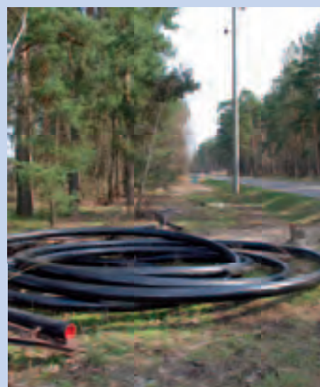
An der Straße zwischen Frankenförde und Züllichendorf wurde bereits die Abwasserdruckleitung nach Frankenförde verlegt.
