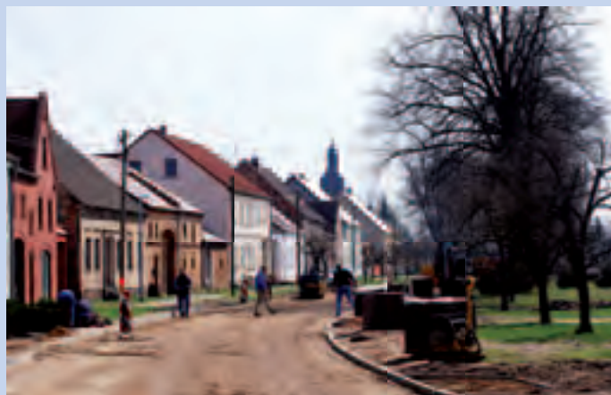
Zügig gingen die abschließenden Arbeiten im Ortskern von Frankenförde voran.
